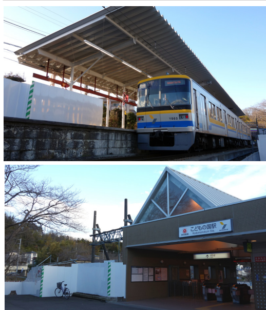
▲完成間近の新しい屋根! ▲進むトイレ設置工事
